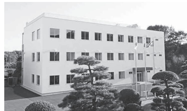
完成した本社社屋
