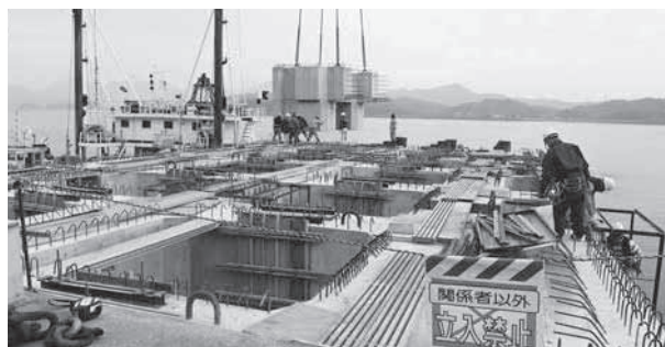
コンクリートブロックの設置
