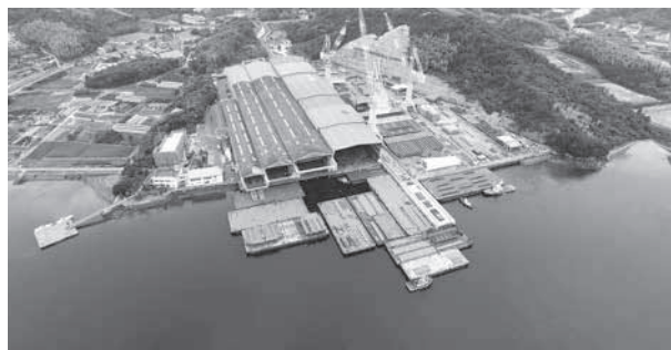
完成後の全景
