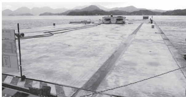
コンクリート打ち完了
