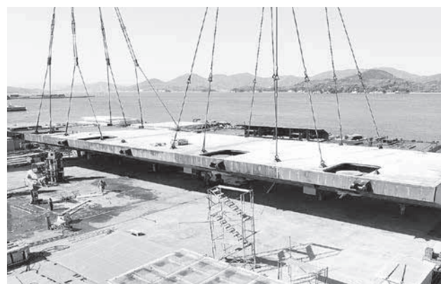
三和ドック殿向けドックゲートの積出し
