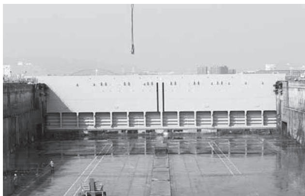
神戸造船所に据付けられたドックゲート
