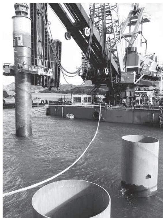
杭打ちの様子
